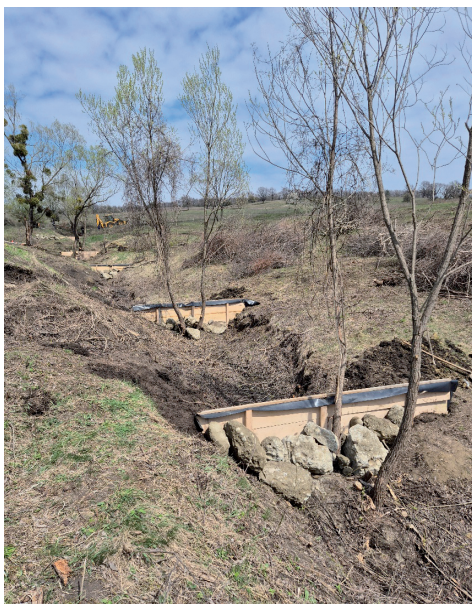
Fotó: Bencze Szilvia. Cserefa foszniból készült fenékküszöbök, Székelypetek
