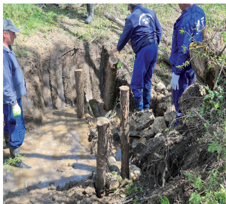
Fotó: Bencze Szilvia. Kővel megerősített rönkgátak építése az Olt Vízügy Igazgatóság által a kadasztrált patakban Székelydályában. A kis erecske egy nap alatt feltöltötte a patakmedret.
