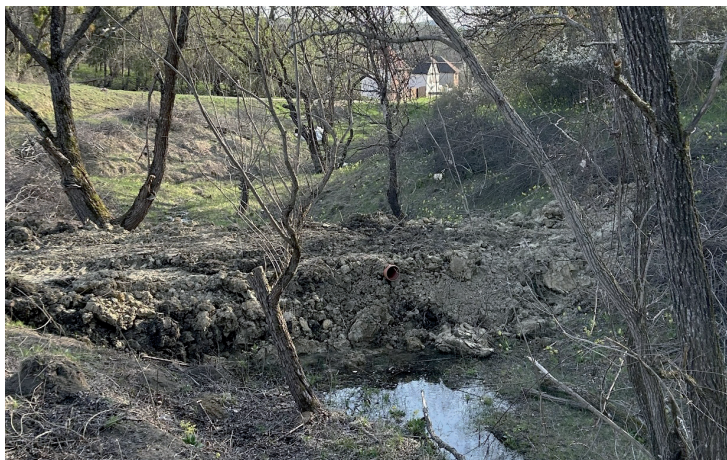
Fotó: Both Tünde. Ledöngölt földgát áteresszel, Székelypetek
